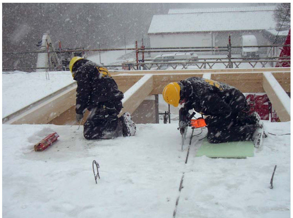
Montage einer Fertigteilplatte mit FT-Verbindern auch bei winterlichen Verhältnissen
