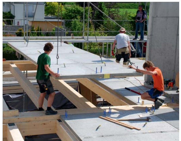
Verlegen/Montieren einer Fertigteilplatte mit FT-Verbindern auf Balkenlage (hier inkl. integrierter Massenaktivierung für Heiz- und Kühltechnik)
