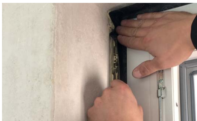
Bild 8: Ausbildung eines luftdichten Anschlusses im Eckbereich Sturz zu Laibung
