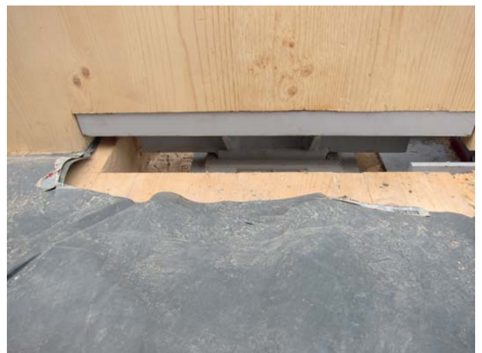
Krafteinleitung vom wandartigen Träger in die Stütze
