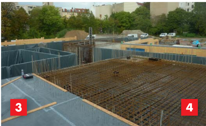
Bauablauf: 1: Brettsperrholzwände 2: Stahlbetonwände 3: Brettschichtholzdecken 4: Stahlbetondecken
