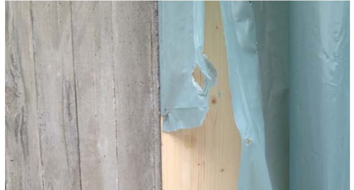
Übergang Holz-Beton nach dem Ausschalen
