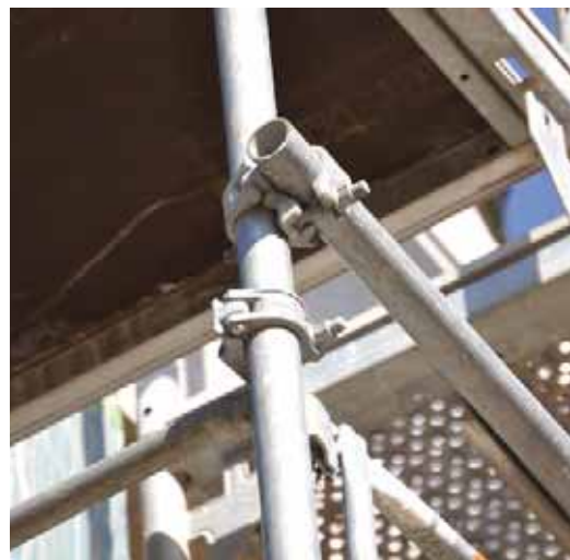
Bild 5. Verbindung zweier Rohre mit einer Normalkupplung
