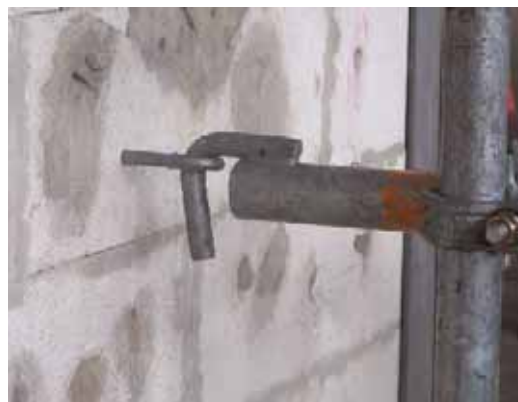
Bild 6. Verankerung eines Fassadengerüsts mit kurzem Gerüsthälter und Ringössenschraube
