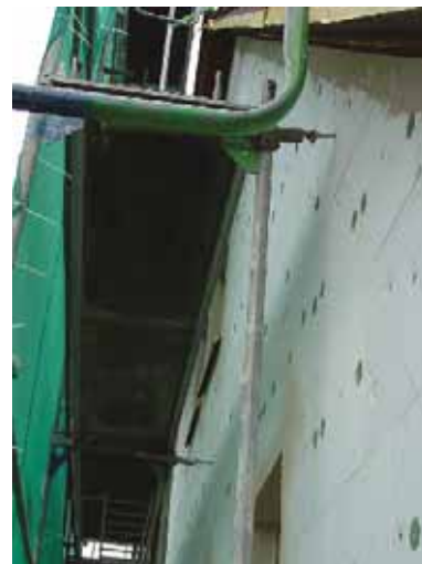
Bild 12. Befestigung eines Arbeitsgerüsts mit langen Ringöschenschrauben bei Montage eines WDV-Systems
