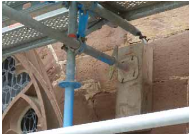
Bild 16. Einleitung der Zugkräfte über eine kurze Ringöschenschraube und der Druckkräfte über eine Druckabstützung bei einem historischen Altbau
