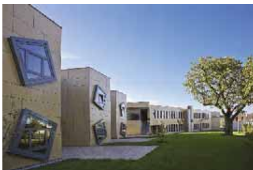
Bild 54. Fensterelemente vor der tragenden Wand, kein zusätzlicher Schutz vor einem Absturz bei Versagen der Befestigungsmittel
