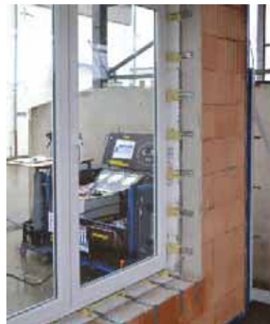
Bild 75. Montagesituation im Bereich der Brüstung und der Laibung mit Konsolen in einem Ziegelmauerwerk [36]
