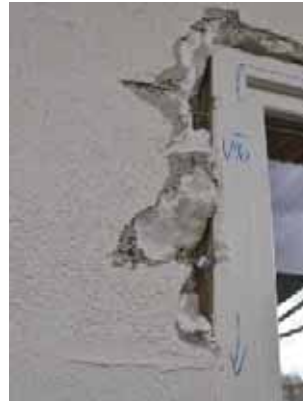
Bild 77. Manueller Angriff auf die Verbindung Konsole – Fensterprofil [36]
