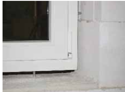
Bild 57. Detail der verwendeten Versuchswand aus Porenbeton PPW 4 und der Befestigungsanordnung in der Widerstandsklasse WK 2 [34]
