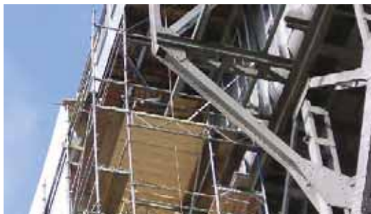
Bild 2. Hängegerüst mit flächenorientierten Gerüstlagen
