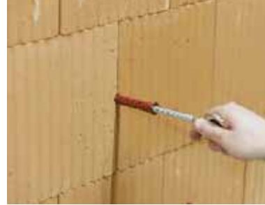
Bild 24. Montage des Kunststoffdübels W-UR 14 SymCon in der Stoßfuge einer Wand aus Hochlochziegelsteinen
