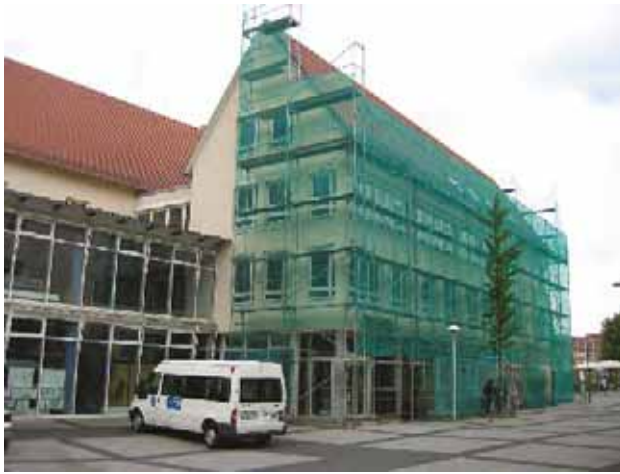
Bild 9. Fassadengerüst mit engmaschigem Netz
