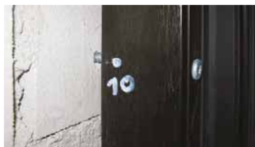
Bild 32. Montage eines Fensterrahmens mit einer Abstandsmontageschraube mit Panheadkopf
